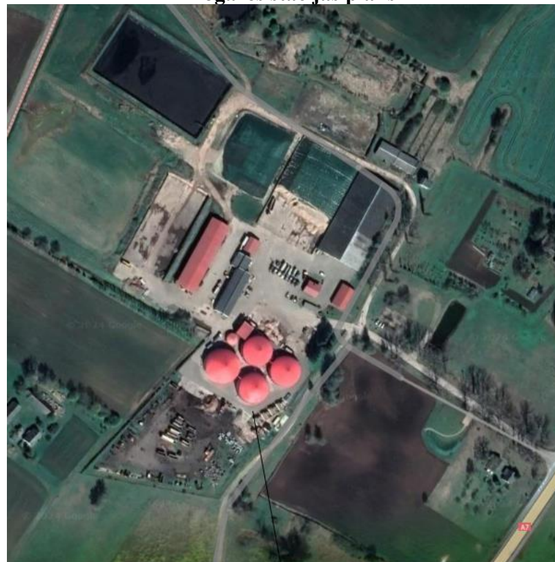
SIA „BM Holding” esoša biogāzes koģenerācijas stacija
