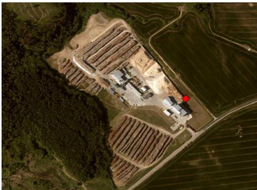
SIA "Technological Solutions" NAI novietojums
