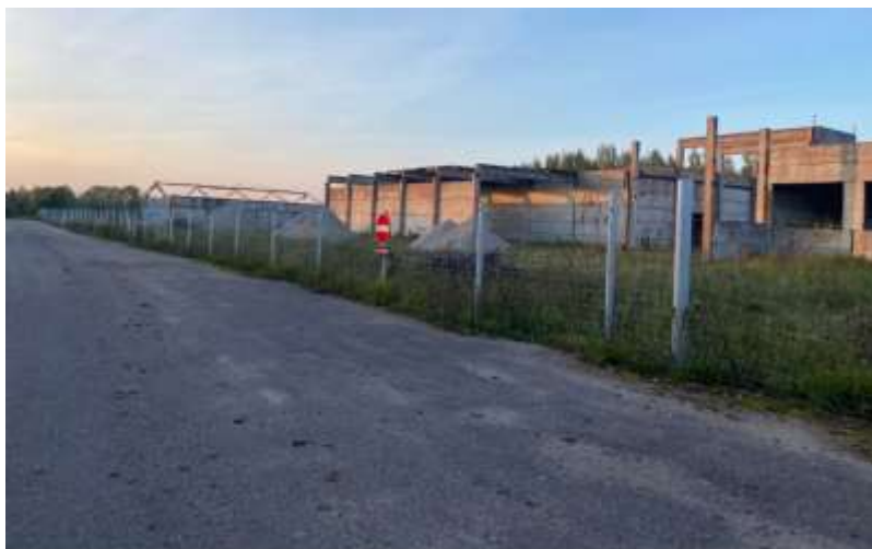
2.attēls Zemes gabalā atrodas būves (karkasi), foto 2022.gada pavasarī
