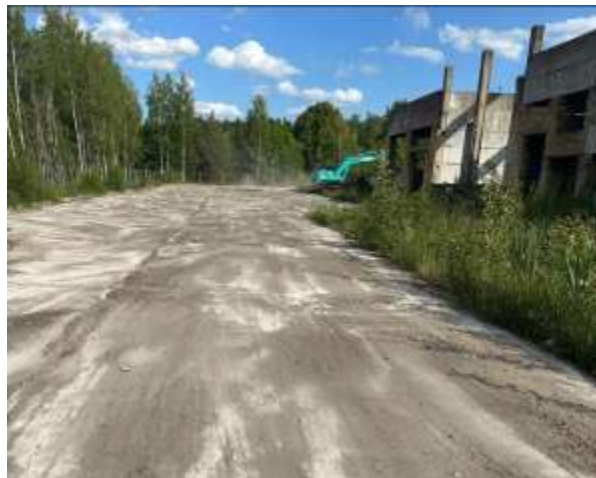
3. attēls Ūdensnecaurlaidīga monolīta betona segums ar deformācijas šuvēm teritorijā, foto 2023.gada pavasaris
